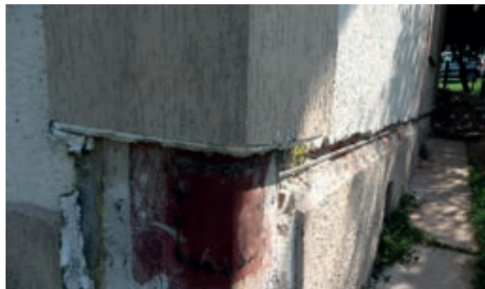
Příklad dodatečného zajištění stavby proti tahovým deformacím pomocí ocelových kotev, které jsou následně zakryty povrchovou úpravou stavby Foto: Eva Jiráňková
